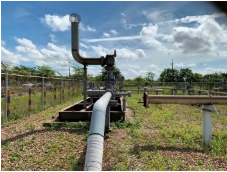
ภาพที่ 2.2-41 การติดตั้ง Pressure Relief Valve
