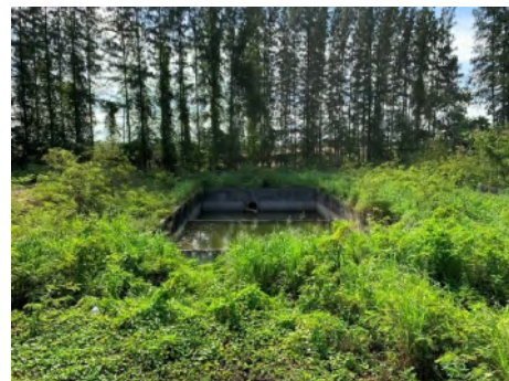
ภาพที่ 2.2-14 บ่อตกตะกอนสำหรับรองรับน้ำฝน บริเวณพื้นที่ลานกองเศษเหล็ก
