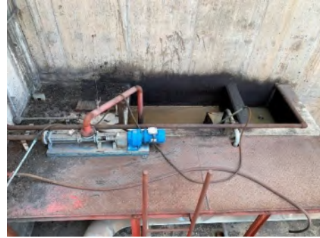
ภาพที่ 2.2-10 ระบบดักตะกอนและแยกคราบน้ำมัน
