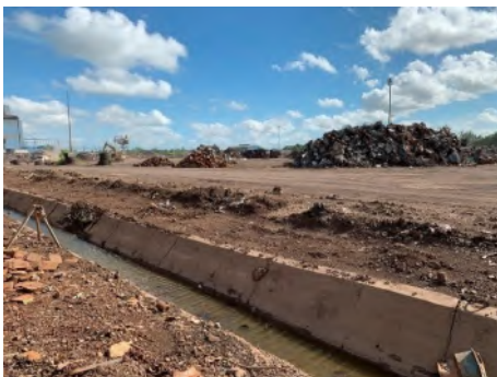
ภาพที่ 2.2-13 รางระบายน้ำฝน บริเวณพื้นที่ลานกองเศษเหล็ก
